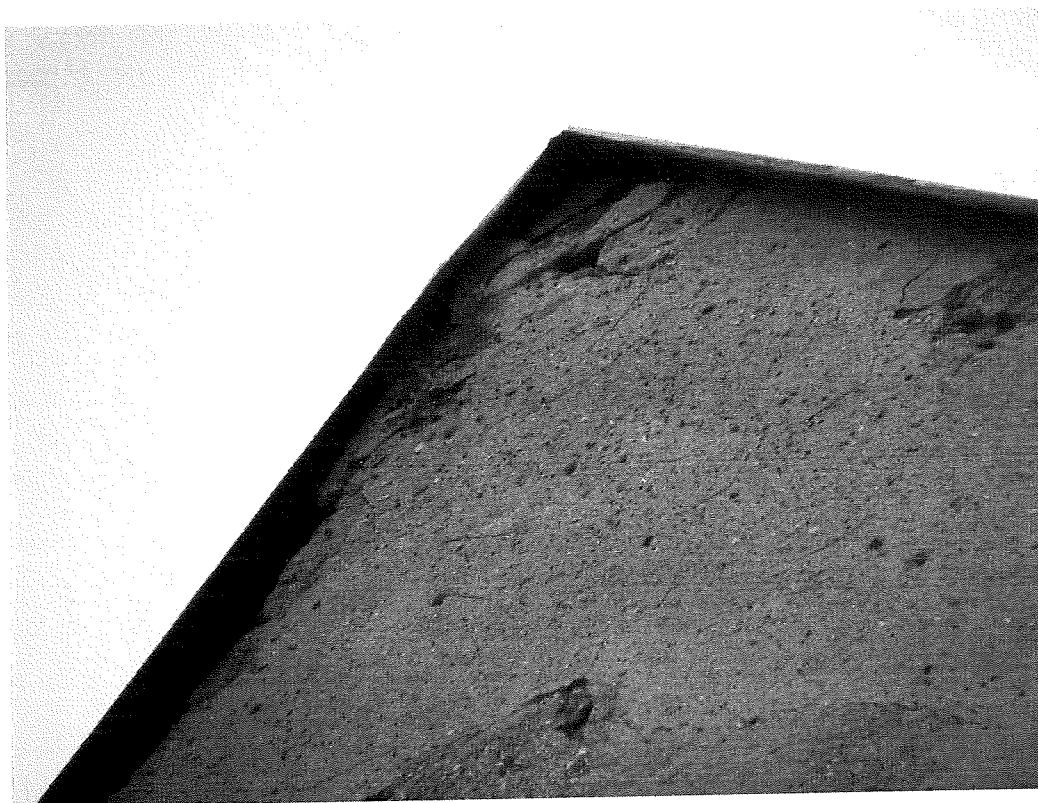
Fot.16. Ubytki w części stropowej w zbliżeniu (aut. Szymon Wójcik).
